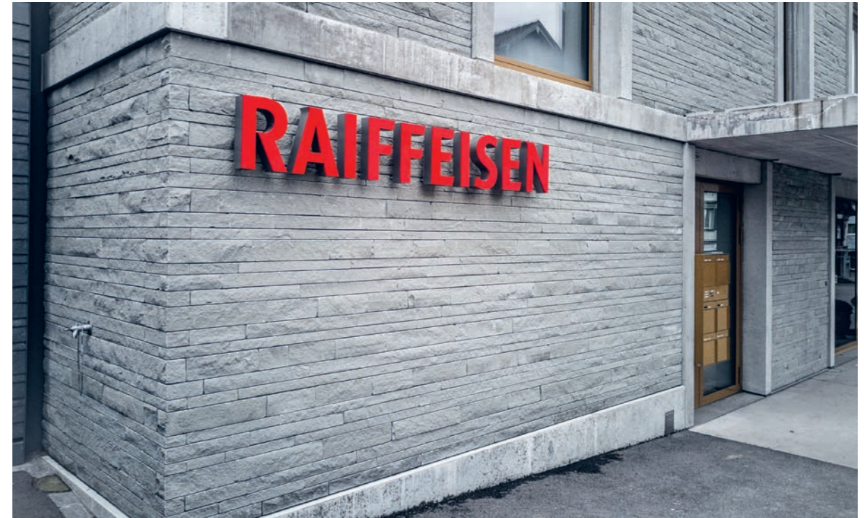
Verblendermauerwerk in Schichten, selbsttragendes Mauerwerk
