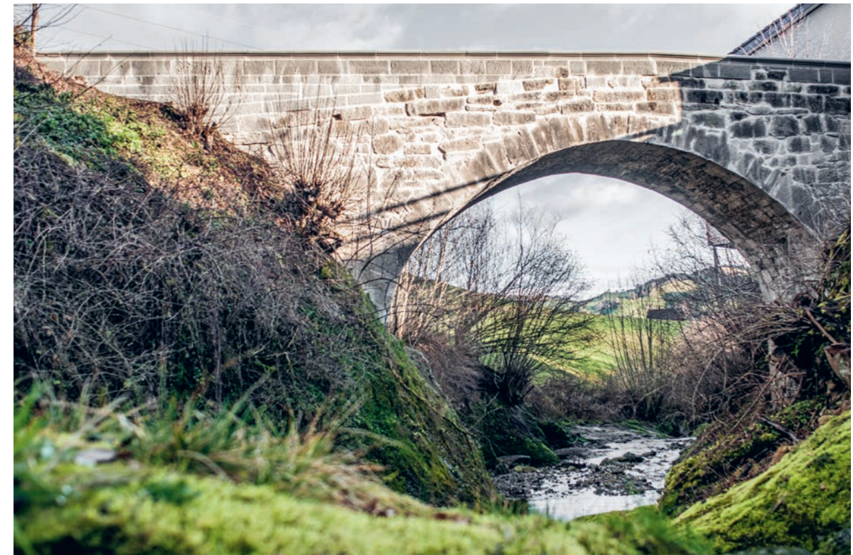
Kesselismühlebrücke, Appenzell Gonten, Ingenieur: Jürg Conzett
