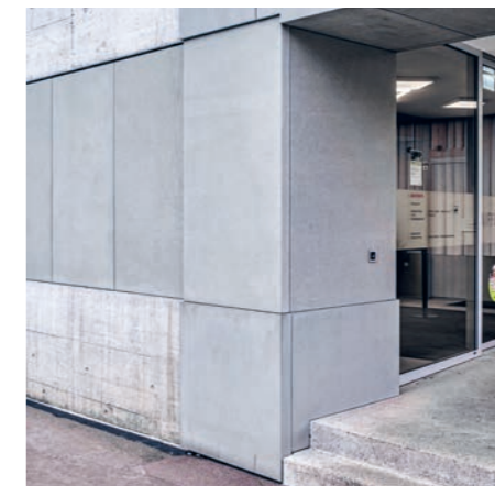
Raiffeisenbank, Gossau Zimmer Schmidt Architekten
