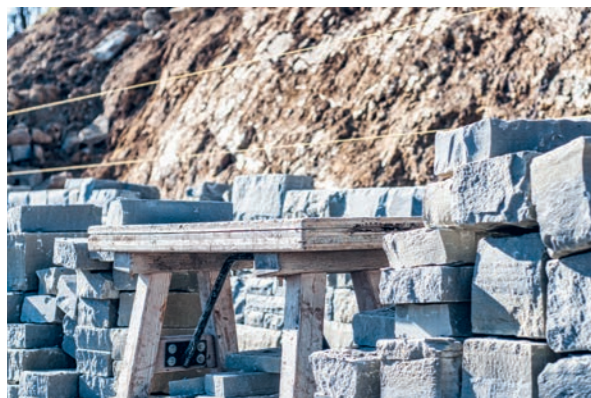
Aufbau einer Trockenmauer.
