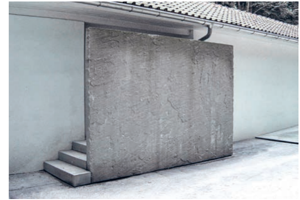
Sichtschutzplatte als Windfang
