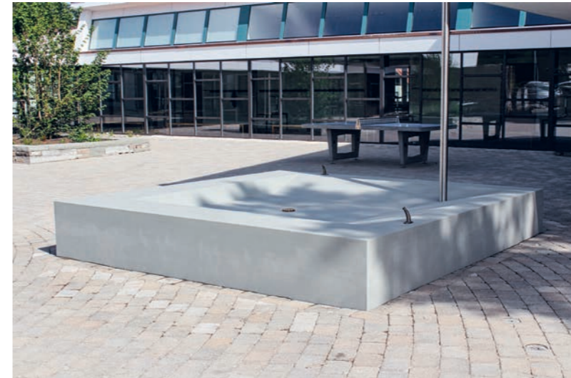
Brunnen Schulhaus Steinlig, Bassersdorf, 3,5 x 3,5 m Bucher Partner Architekten + Artenreich Bolliger Gärten
