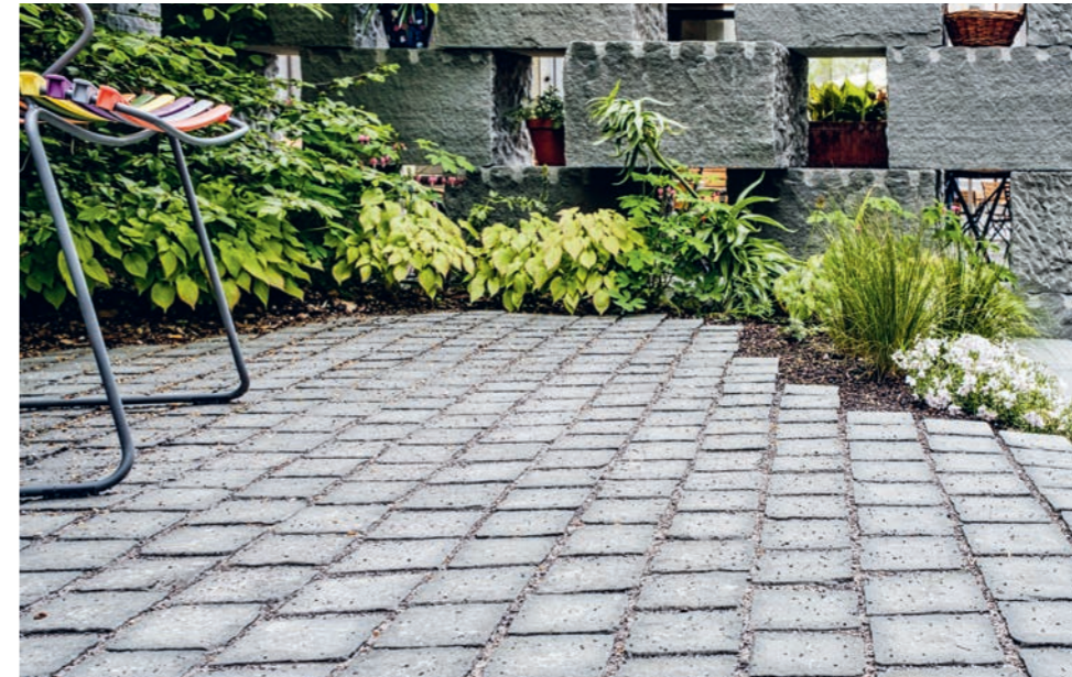
Reihenpflasterung, gepflastert mit Pflastersteinen 8/11, privater Sitzplatz
