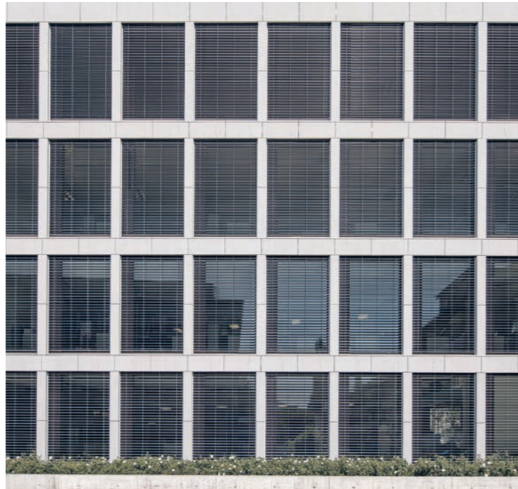
SVA St.Gallen, EHLE Architekten
