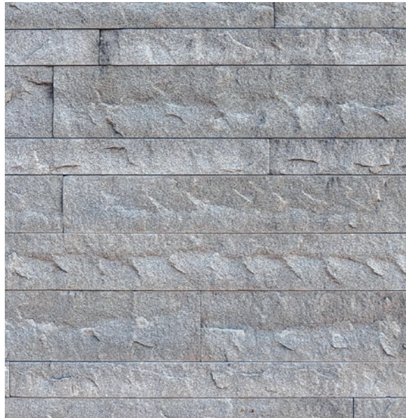
Mauerverkleidung aus Verblenderriemchen gespalten, auf Unterkonstruktion geklebt
