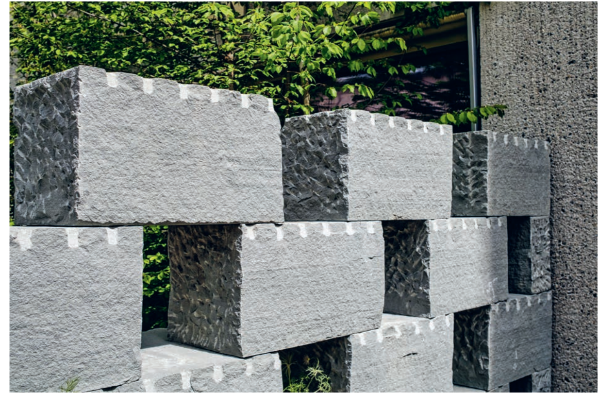
Sichtschutzmauer (Filtermauerwerk) Verbauungssteine handgespalten, Keilspuren sichtbar, Sichtkopf gespitzt
