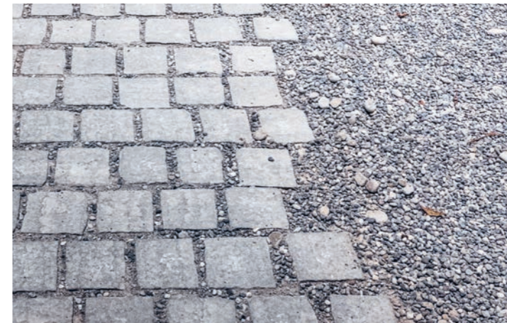
Reihenpflasterung, gepflastert mit Pflastersteinen 8/11, Übergang zu Kiesfläche
