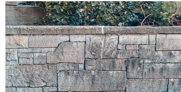
Abdeckplatte geflammt, Kanten roh, bündig versetzt, Privatgarten
