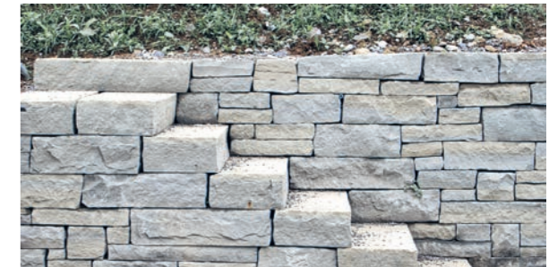
Mauerdeckel, flächig eingemauert, Privatgarten
