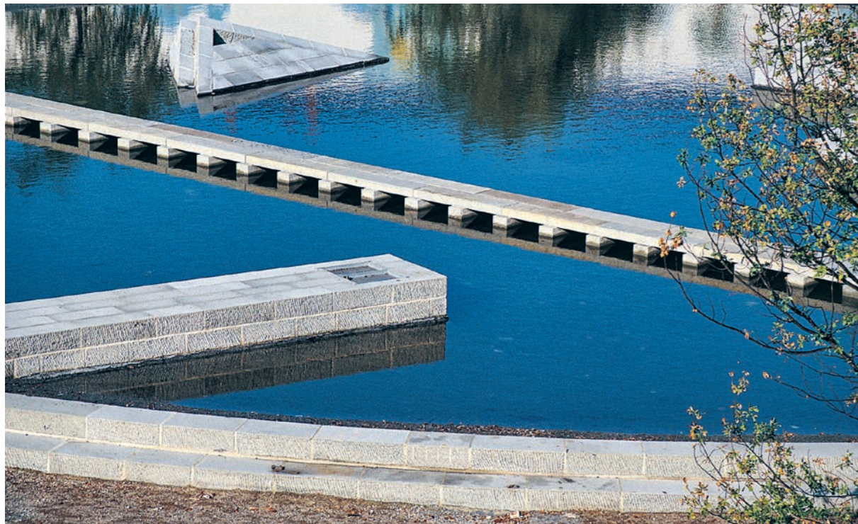
Brunnenanlage aus roh gespaltenen Steinen, Ansichtsflächen handwerklich gespitzt, Hannover Landschaftsarchitekt: Wehberg Lange
