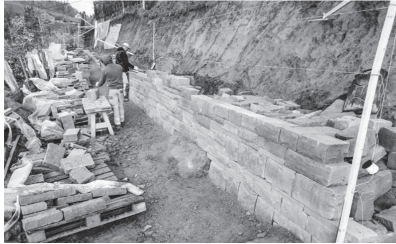
Bau von traditionellen Naturstein-Mauern am Buechberg Thal SG.
