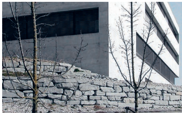
Verbauungssteine wildförmig, als Stützmauer vermauert
