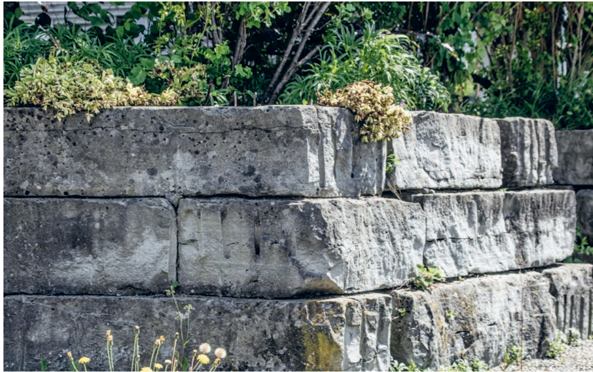
Verbauungssteine maschinengespalten, in fixen Höhen als Stützmauer
