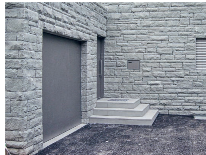
Verblendermauerwerk, schottisch vermauert, selbsttragendes Mauerwerk
