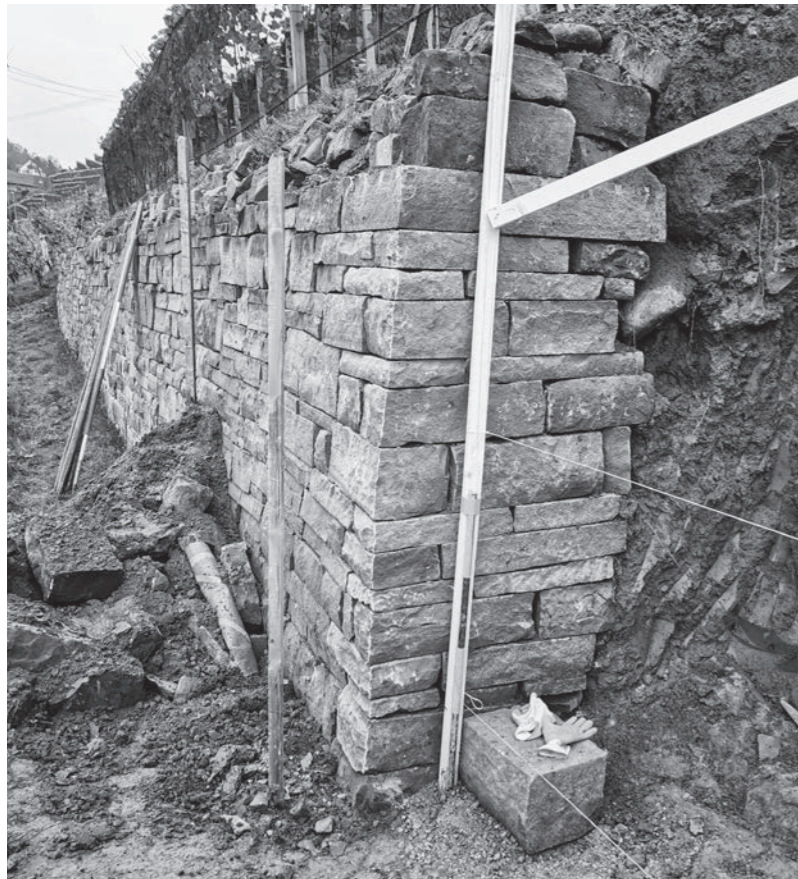
Bau von traditionellen Naturstein-Mauern am Buechberg Thal SG.
