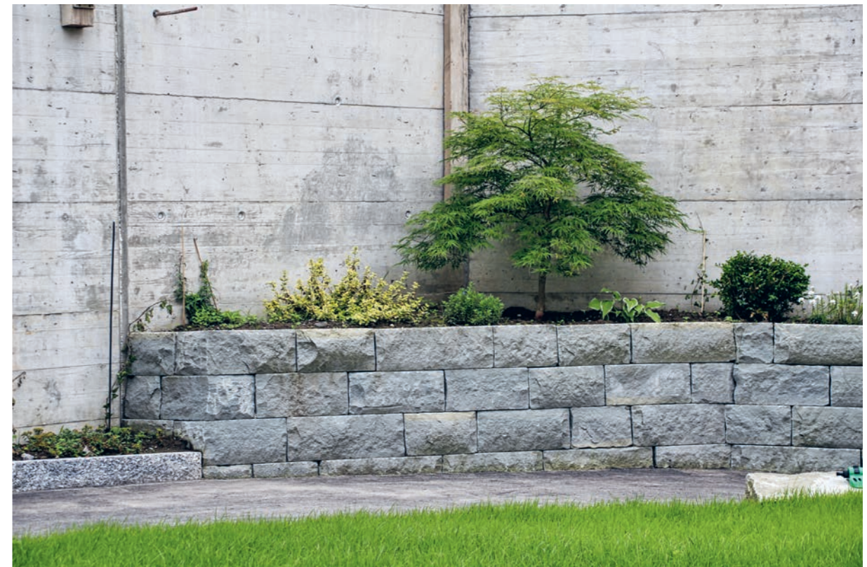
Stützmauer aus Mauersteinen roh für Trockenmauern in fixen Schichten.
