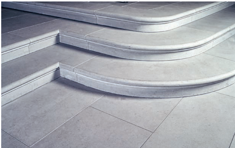
Tritt- und Stirnplatte, geschliffen, Trittplatte profiliert
