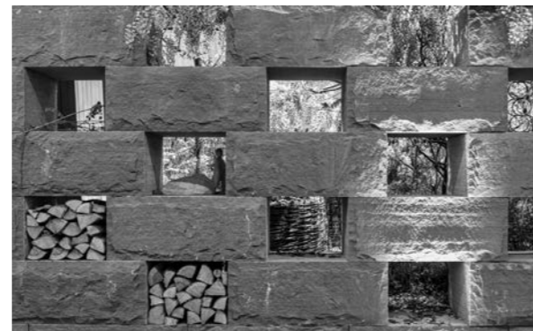
Gestaltungsquader mit gesägten Lager- und Stossfugen als Filtermauerwerk handgespalten, Keilspuren entfernt
