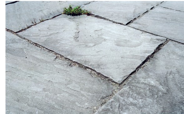
Bodenplatten, Oberfläche und Kanten roh gespalten, Römischer Verband
