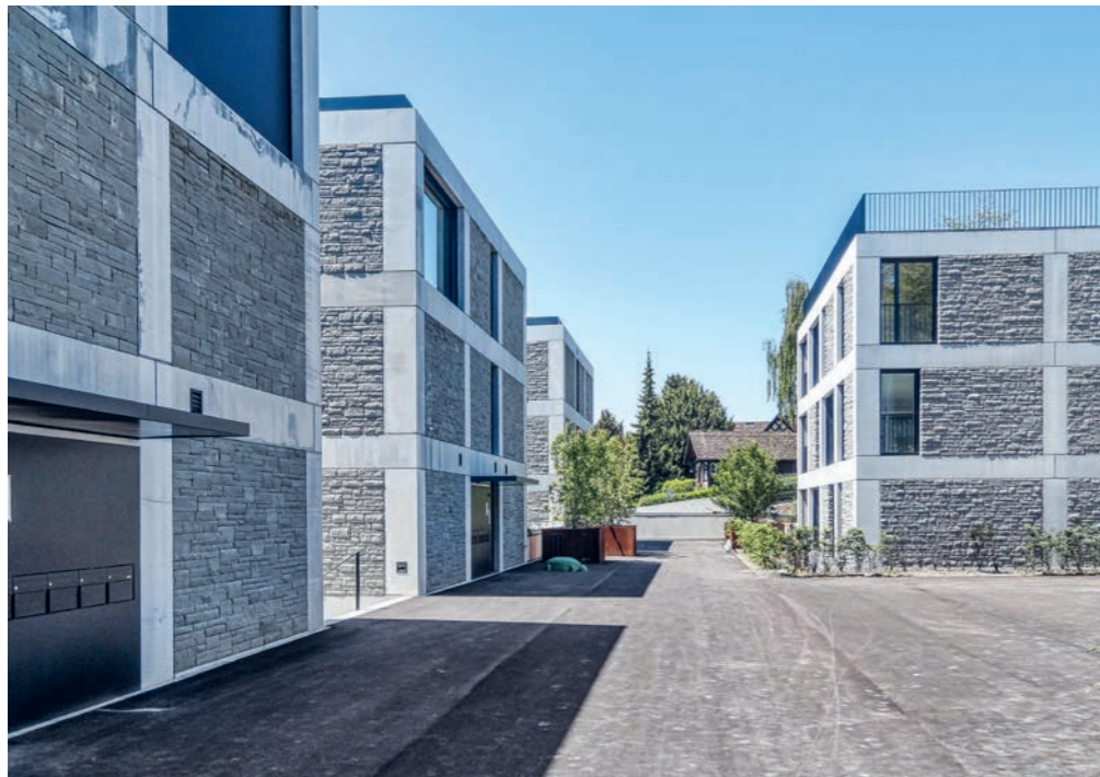
Verblendermauerwerk, schottisch vermauert, selbsttragendes Mauerwerk
