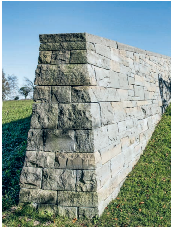
Trockenmauern freistehend, aus Mauersteinen roh für Trockenmauern, Weinberge in Thal SG.
