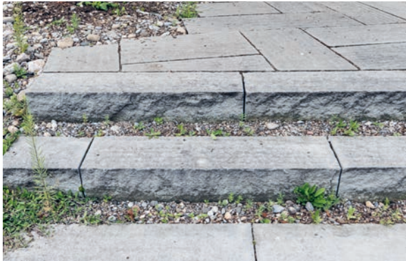
Blockstufe geflammt, Belag mit Bodenplatten geflammt
