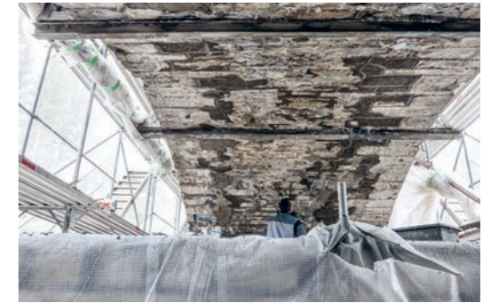
Bogenuntersicht der Kesselismühlebrücke
