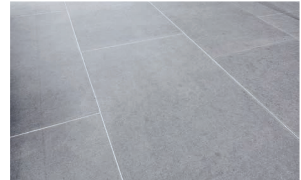
Bodenplatten geschliffen, in Bahnen, freie Längen
