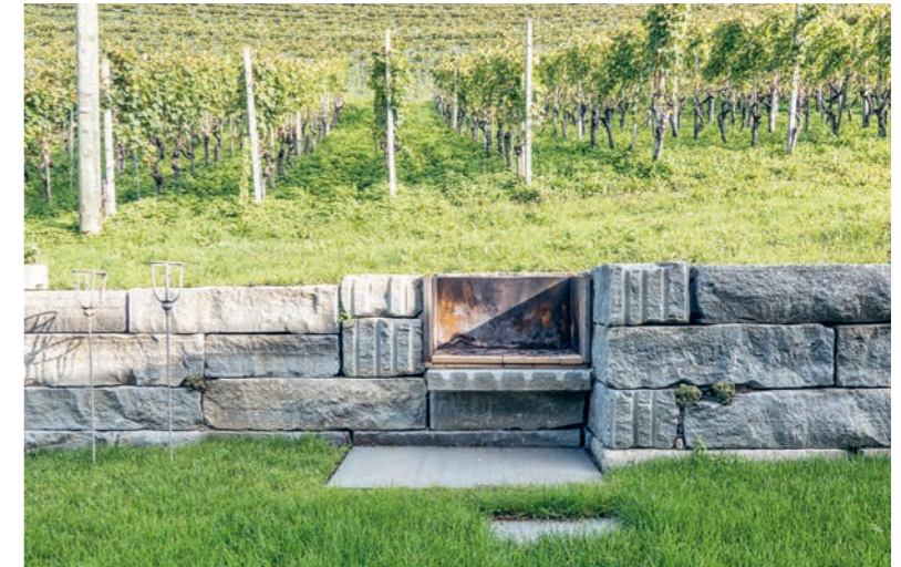
Privatgarten, Stützmauer aus maschinengespaltenen Verbauungssteinen, gemischte Grössen mit freien Höhen
