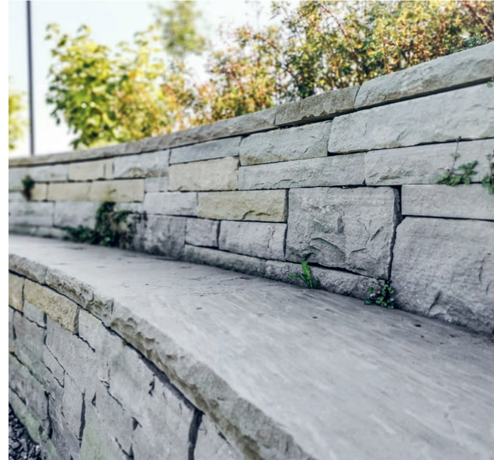
Abdeckplatte bearbeitet, einhäufig, als Sitzmauer, MoMö Museum der Mosterei Möhl, Arbon
